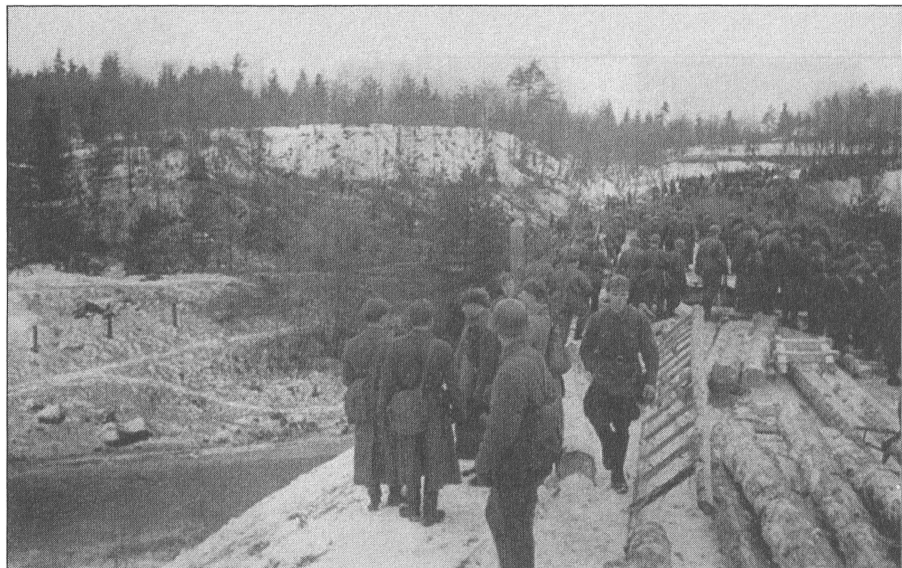
Саперы на строительстве моста в районе финляндской пограничной заставы Япинен. Действующая армия. 1939 г.
