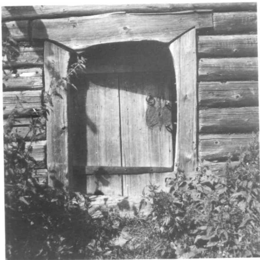
Saunan ovi, jossa on karjalaistyyppinen lukkolevy. Pihtipielen ja kamanan konstruktio vastaa marmori- tai hiekkakivirakennetta. Valok. Helmi Virtaranta 1958, Tverin Karjala, Tolmatsun piirik., Kujazdovin kylä. Museovirasto.
