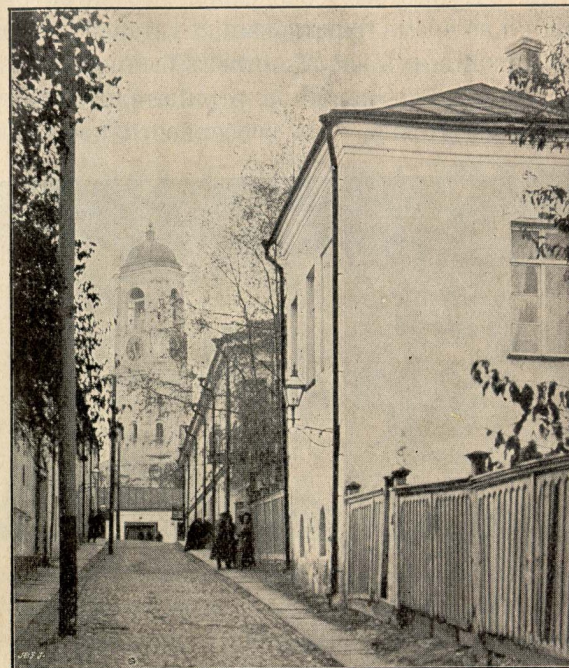
Часть средневѣковаго Выборга на Водоворотной ул. № 4.
