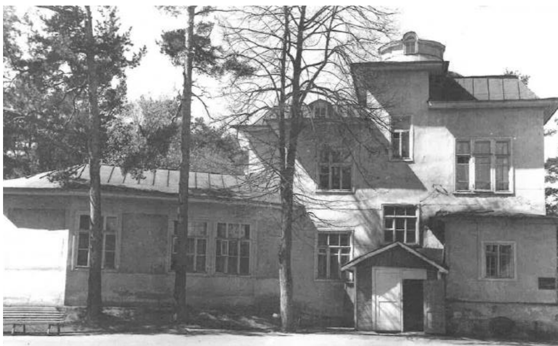
32. Дача Л.Ф. Фертиг (О.О. Грузенберга). Восточный фасад. Фрагмент. 1996 г.
