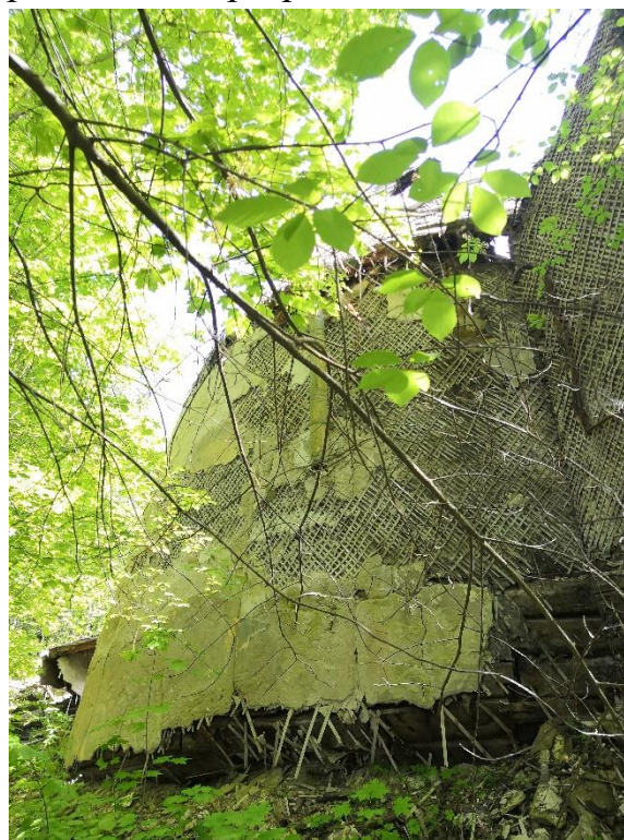
Фото. 15. Вид с севера
