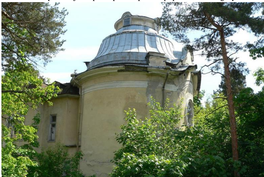
37. Дом Л. Ф. Фертиг (О.О. Грузенберга) (Лесная д. 9) до пожара, 17.06.06. Фото М. Браудзе [Электронный ресурс] URL:
