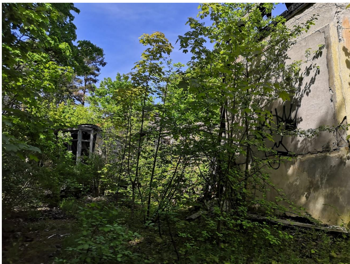
Фото. 1. Вид на здание с юго-востока
