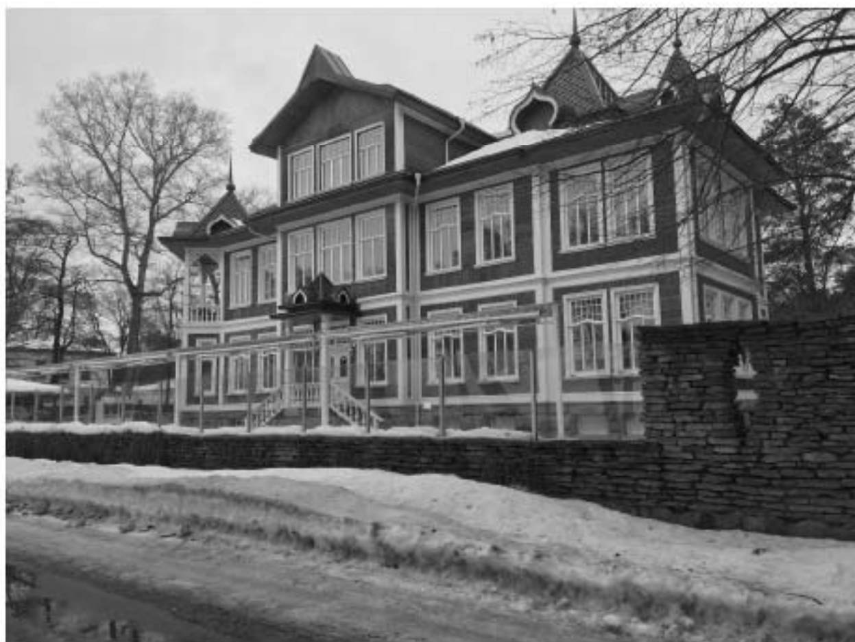
Фото 7. Вид на западный фасад здания по адресу ул. Парковая, д. 16, лит. Д.
