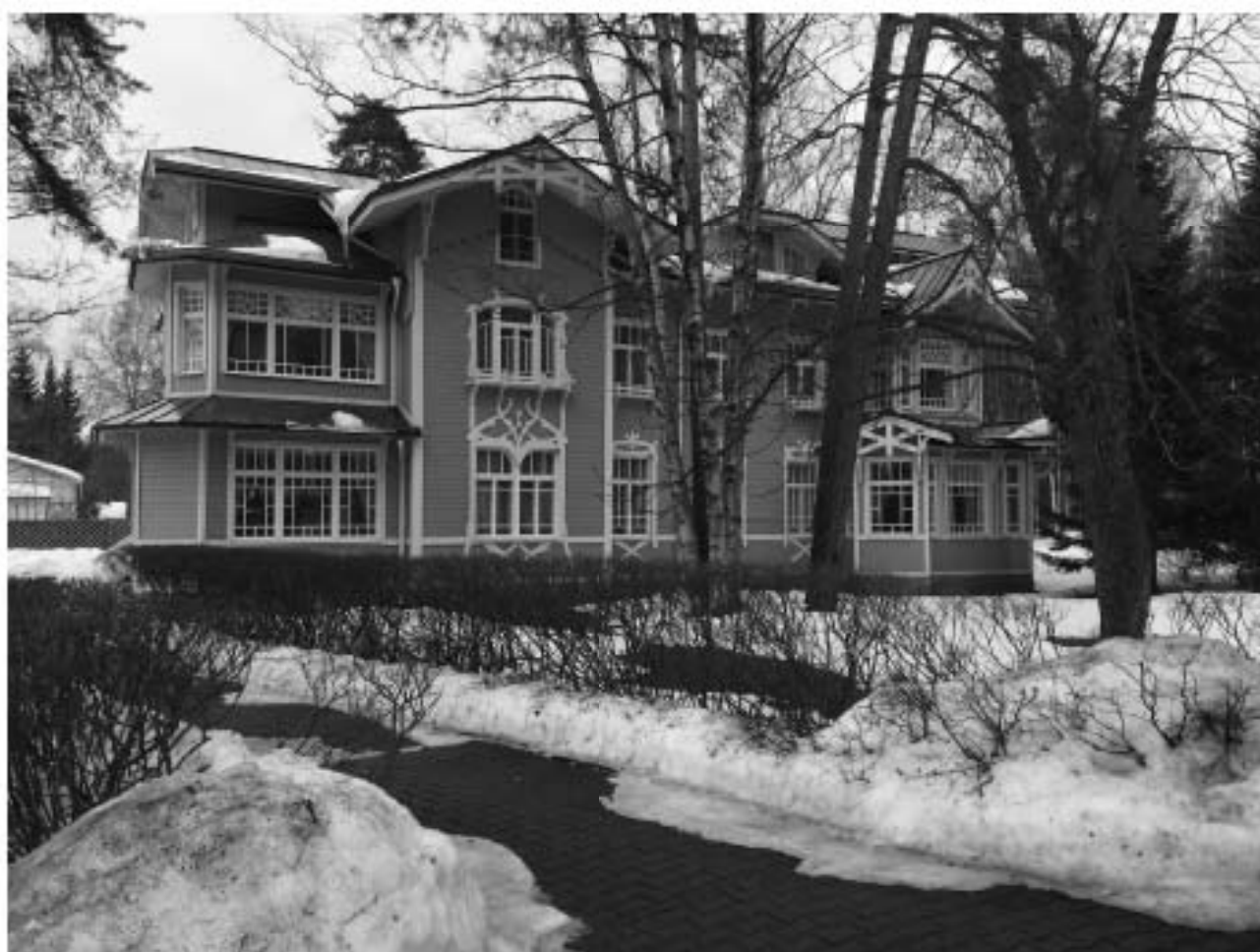
Фото 9. Вид на южный фасад здания по адресу Парковая ул., 16, Лит А - Дача В.Г. Лихачева
