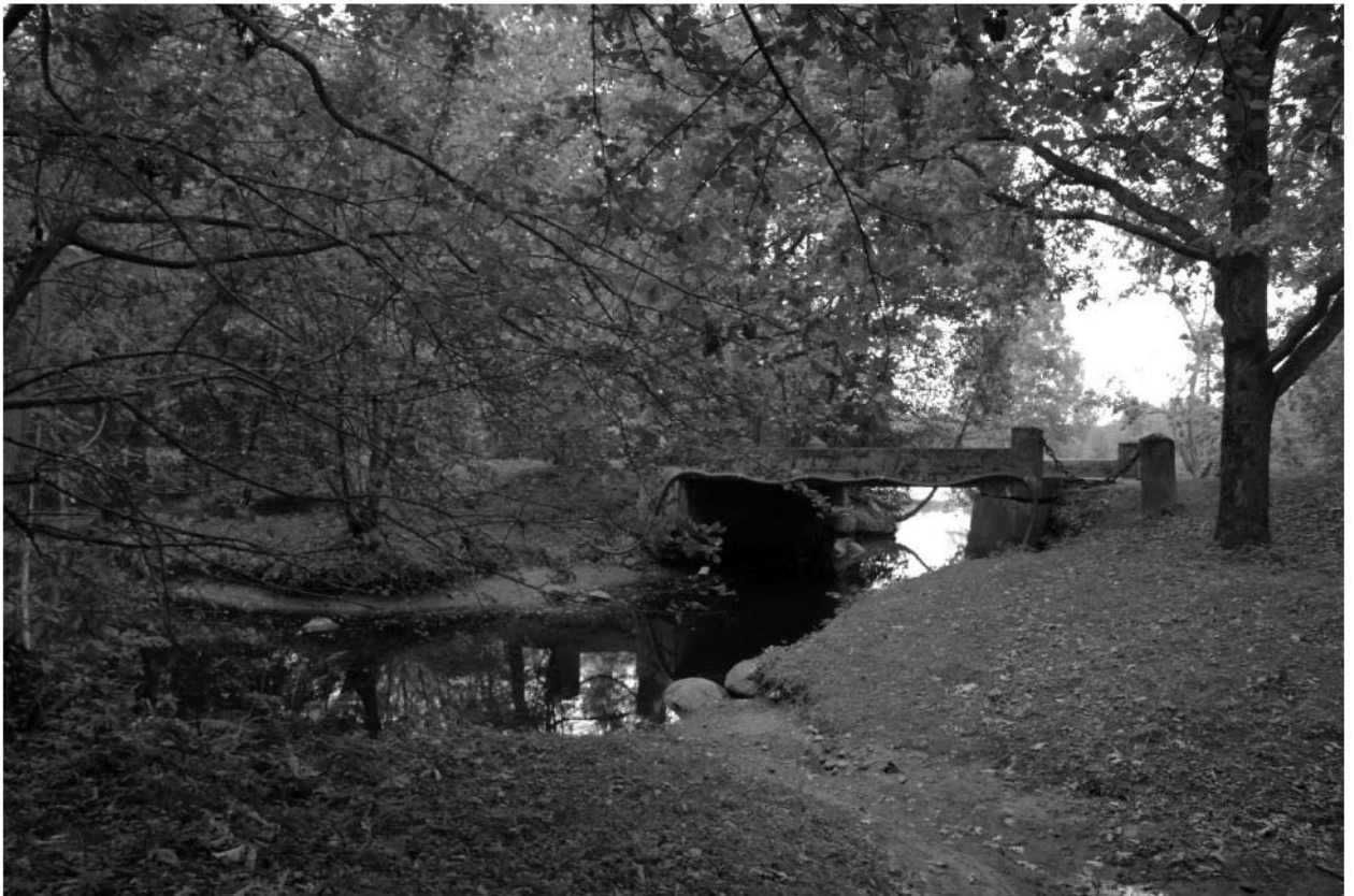
Фото 3. Железобетонный мост над протокой, соединяющей гидросистему Голландского сада с безымянным прудом.
