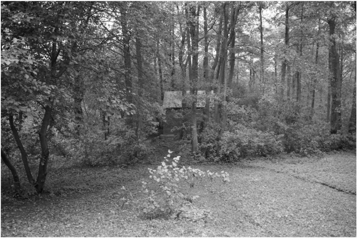
Фото 5. Здание туалета в южной части парка.
