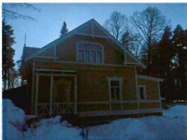
1. Здание дачи. Северный фасад.
