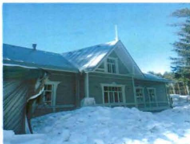
4. Здание дачи. Восточный фасад.
