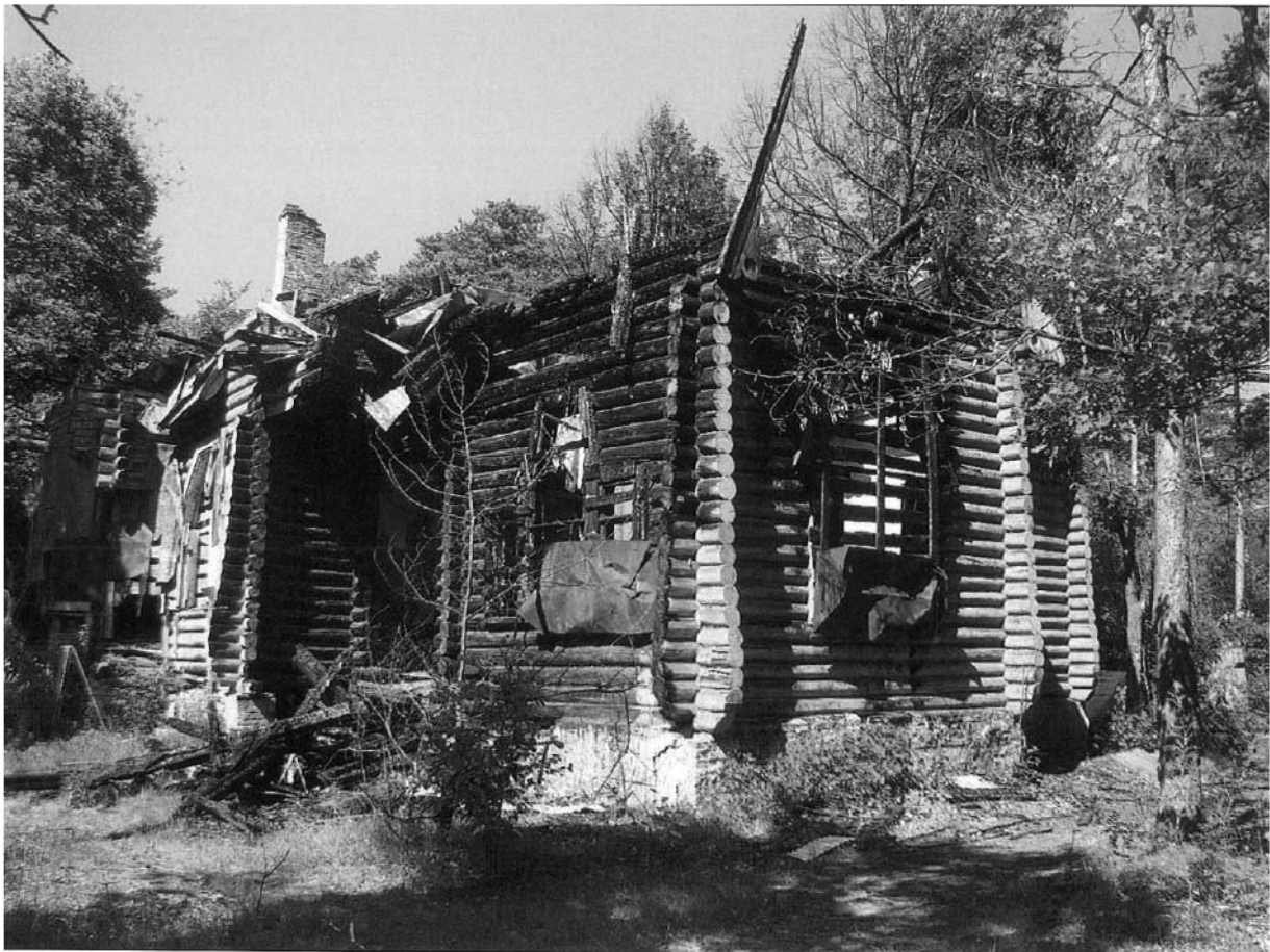
13. 2010 год. Юго-западный и восточный фасады. Утраты после второго пожара 2009 года.
