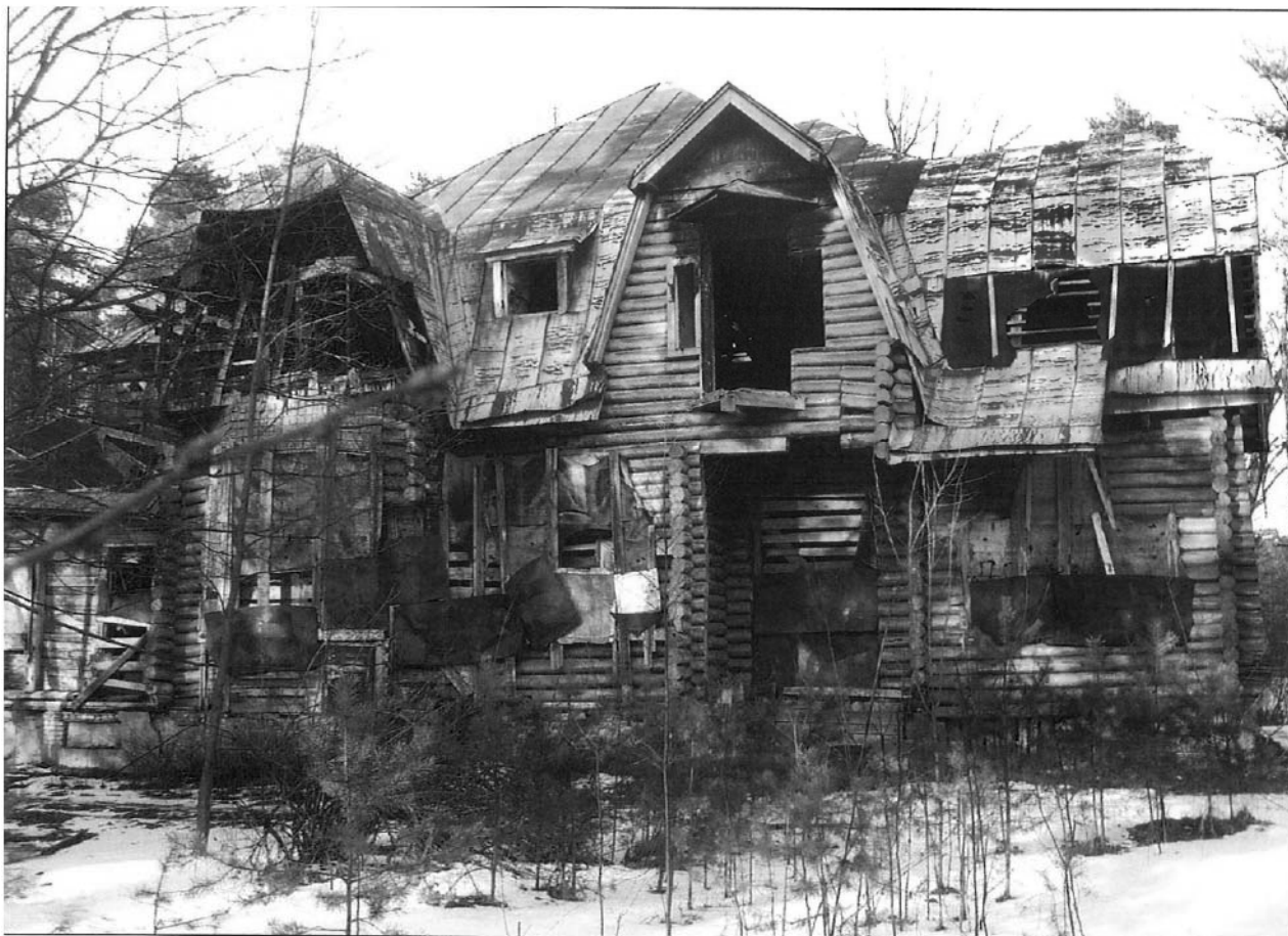
9. 2008 год. Главный юго-западный фасад. Объемно-пространственное решение, несмотря на утраты после первого пожара соответствует историческому.
