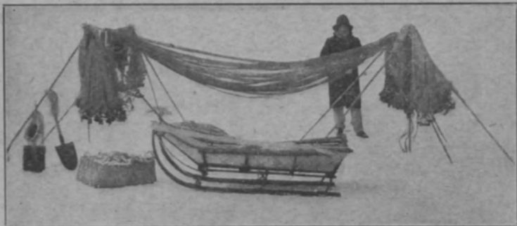
Putkikalastajan varusteita. Kuvassa näkyvillä lapiolla, joiden lyhyen varteen on sidottu pitkä nuora, aikaansaadaan verkkokalastuksessa välttämätön jäänalainen yhteys kahden avannon välille, jotka voivat olla jopa 70 m:n päässä toisistaan, lähettämällä ne läheisistä avannoista toistaan vastaan, jolloin toista lapiota ylös vedettäessä, toisen nuora tarttuu ensinmainitun lapiion varren ja nuoran kulmaan. — Valok. E. Helleaara.
