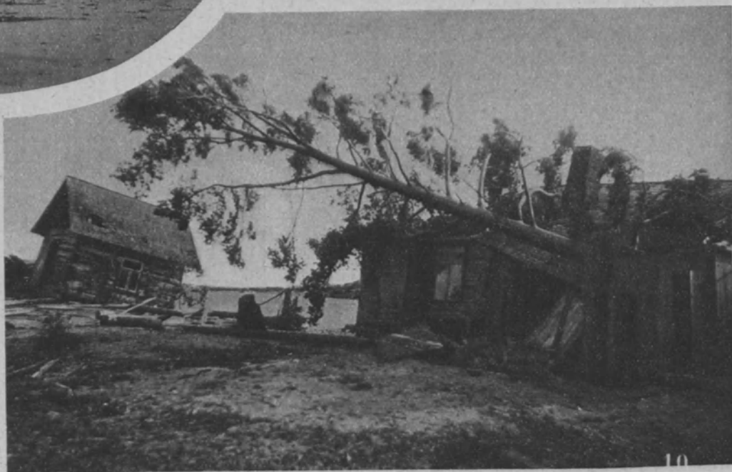
9 ja 10. Kalastaja Nokkosen asunto Terijoella. Merenpuoleiselta seinustalta veivät aallot perustukset runnellen koko rakennuksen keloittomaksi. Yläkuvassa oikealla näkyy aaltojen huuhtoma akkijyrkkä hiekkakumpu. Viereisessä kuvassa nähdään kaatuessaan kalon murskannut rantahonka. — Valok. J. A. Seppänen.
